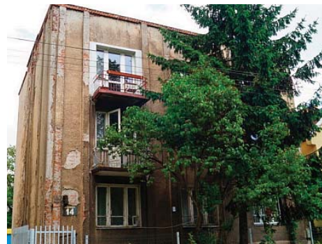
Budynek przy ul. Cienistej 14
