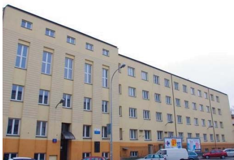
Budynek przy ul. Cyryla i Metodego 4 – stan obecny
