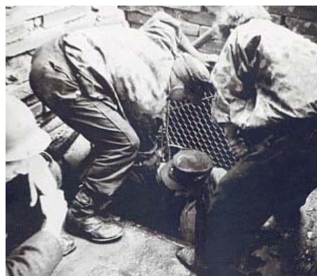
Wyjście z kanału na ul. Wareckiej po przejściu ze Starówki
