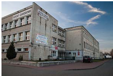
Budynek szkoły przy ul. Mieszka I
