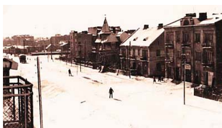
Widok na stronę południową ul. Globusowej. Na końcu ulicy widać kamienicę przy ul. Świerszcza 2 (zima 1940 roku)
