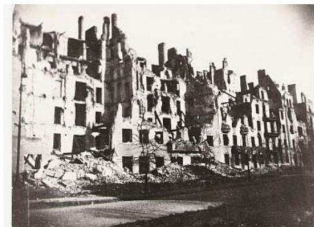
Widok domu od strony ul. Wawelskiej
