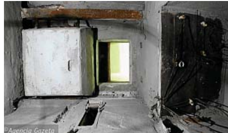
Betonowa zaszuwa – widok od wewnątrz
