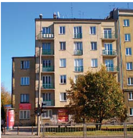
Budynek przy ul. Odyńca 55 – zbudowany od nowa
