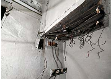
Odnalezione fragmenty instalacji w „Łodzi Podwodnej”
