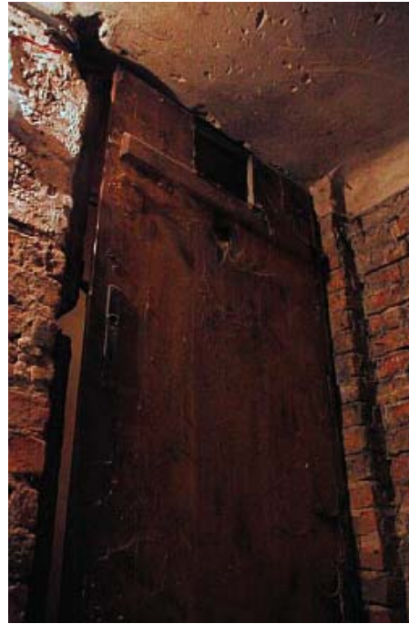
Drzwi do celi w piwnicy
