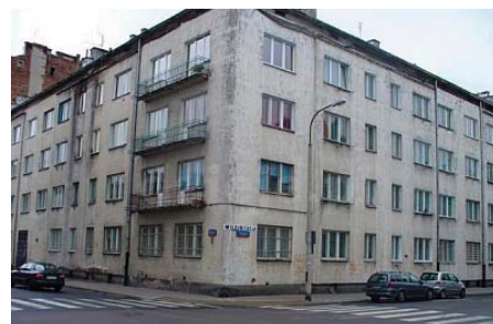
Budynek przy ul. Strzeleckiej 8
