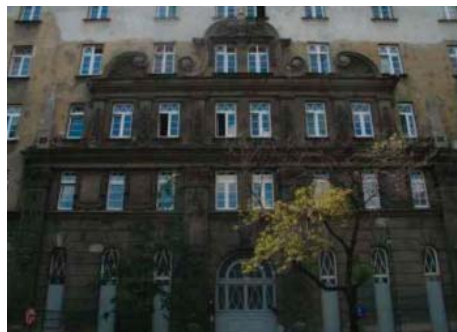
Front budynku dawnego Żydowskiego Domu Akademickiego – wygląd od ul. Sierakowskiego
