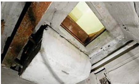
Odsunięty betonowy właz do „Łodzi Podwodnej” poruszający się na szynach i kółkach z łożyskami kulkowymi – widok od spodu
