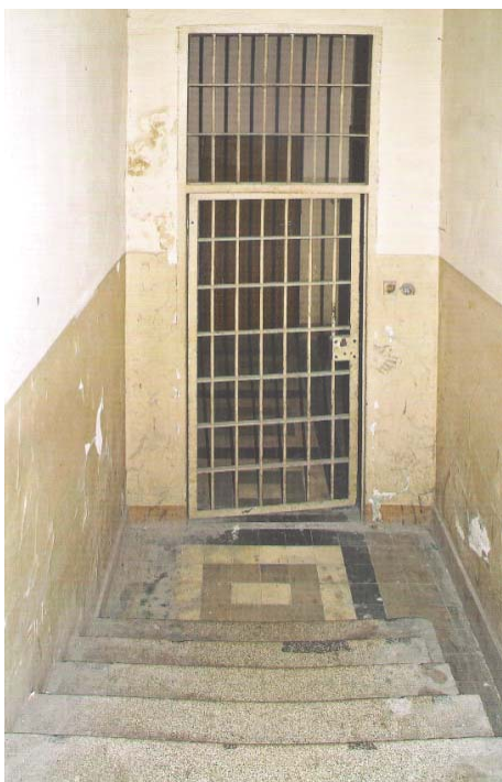
Zejscie do piwnic gmachu dawnego WUBP w Warszawie
