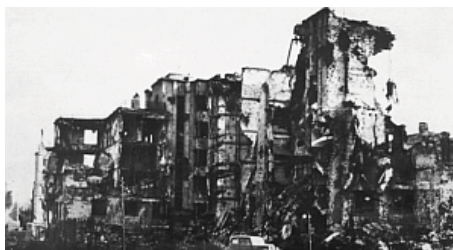
Ruiny budynku mieszkalnego pracowników od ul. Rybaki
