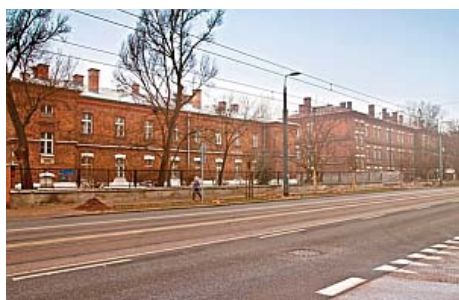
Widok budynków dawnych koszar
