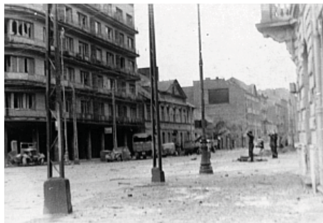
Budynek Nordwache (po lewej) w okresie Powstania Warszawskiego. Widać niemieckie samochody zniszczone podczas polskiego szturmu (ze zbiorów MPW)
