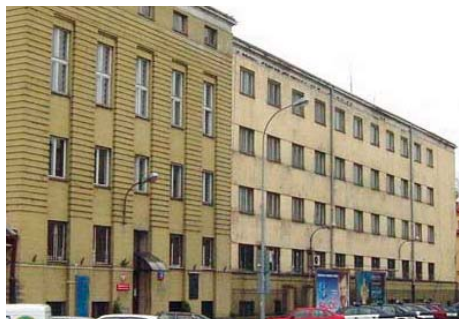
Budynek przy ul. Cyryla i Metodego 4 – stan przed remontem
