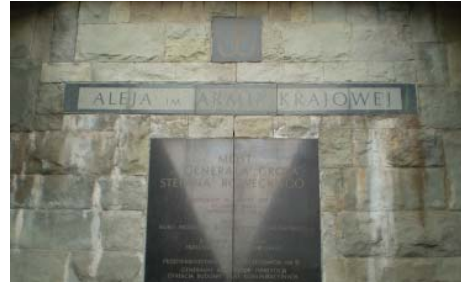
Tablica pamiątkowa pod mostem im. generała Stefana Grota-Roweckiego (na nasypie, przy ścieżce rowerowej, po prawej stronie odcinka Wistostrady w kierunku Łomianek). Jest to tablica dotycząca daty, rozmiarów i wykonawców mostu
