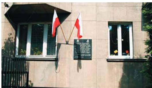
Budynek przy ul. Cienistej 16
