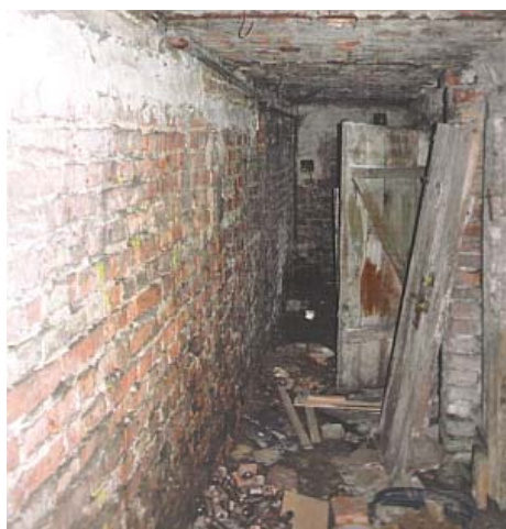
Korytarz piwniczny domu przy ul. 11 Listopada 66
