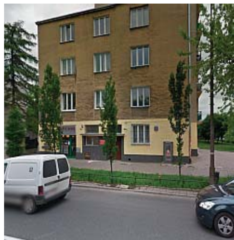
Budynek przy ul. Odyńca 55 – zbudowany od nowa
