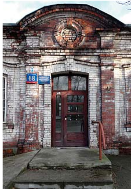
Wejście z prowizoryczną informacją o historii budynku (rok 2011)
