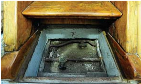
Fragment betonowej wylewki z rurami kanalizacyjnymi i zaworami – ukazuje się po wyjęciu ostatniego schodka. Jest to zamaskowany właz do skrytki
