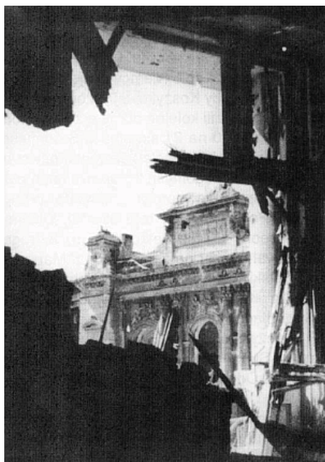
Widok na Gmach Główny Politechniki Warszawskiej ze stanowiska ogniowego przy Noakowskiego 10
