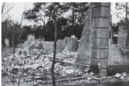
Zniszczona willa przy ul. Słonecznej 16
