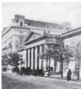
Giełda i kamienica przy ul. Królewskiej 16 (lata 20.)
