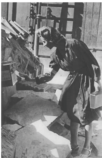
Barykada „Pod skrzynką” na ul. Zielnej
