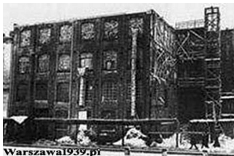
Budynek fabryki Kamlera – po 1945 r.
