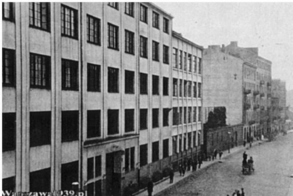
Od lewej: Pawia 55, 57, płot działki nr 59, kamienice nr 61, 63, niższa 65, wyższa nr 67 (budynek na posesji zajmowanej przez fabrykę Szczerbińskiego) i dalsze zabudowania – zdjęcie zrobione przed 1939
