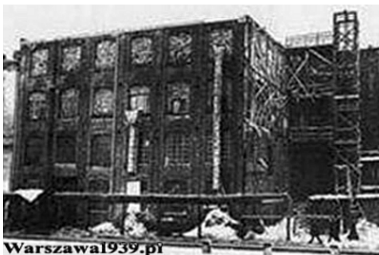
Budynek fabryki Kamlera – po 1945 r.
